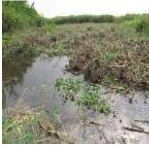
Lancement travaux aménagement rivières
